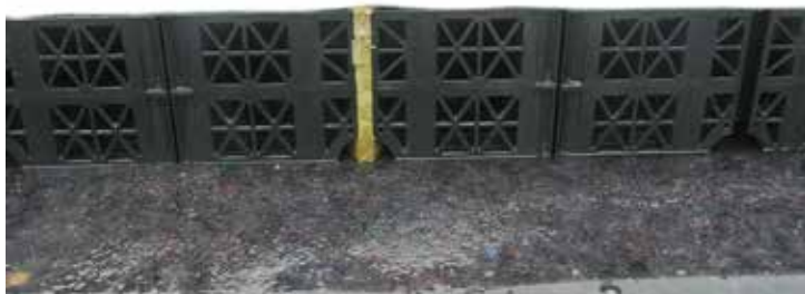
De retentiekragen op scheidingslaag en afgedekt met filterdoek en capillaire cone.
