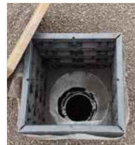
Waterafvoeren blijven toegankelijk via inspectieluiken.
