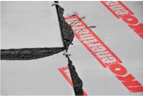
Om verschuiven te voorkomen worden de PIR-platen gekoppeld met kunststof krammen.
