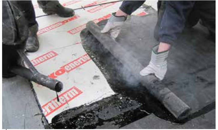
De eerste laag wordt vol en zat gegoten.
