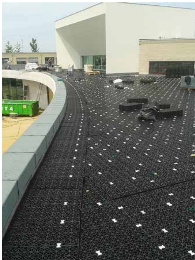
De totale dakoppervlakte is vol gelegd.
