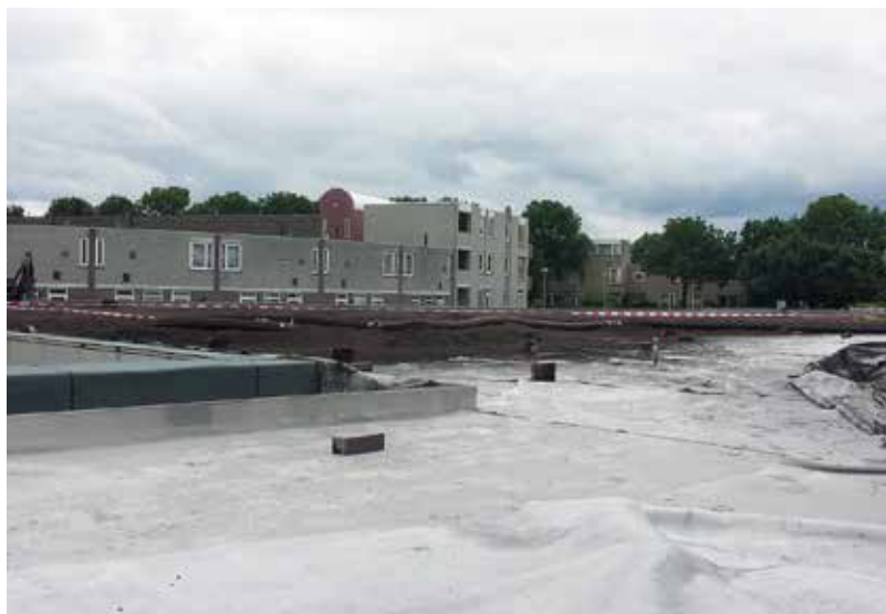
Aanbrengen van het substraat.
