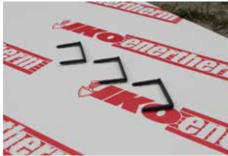
Om verschuiven te voorkomen worden de PIR-platen gekoppeld met kunststof krammen.
