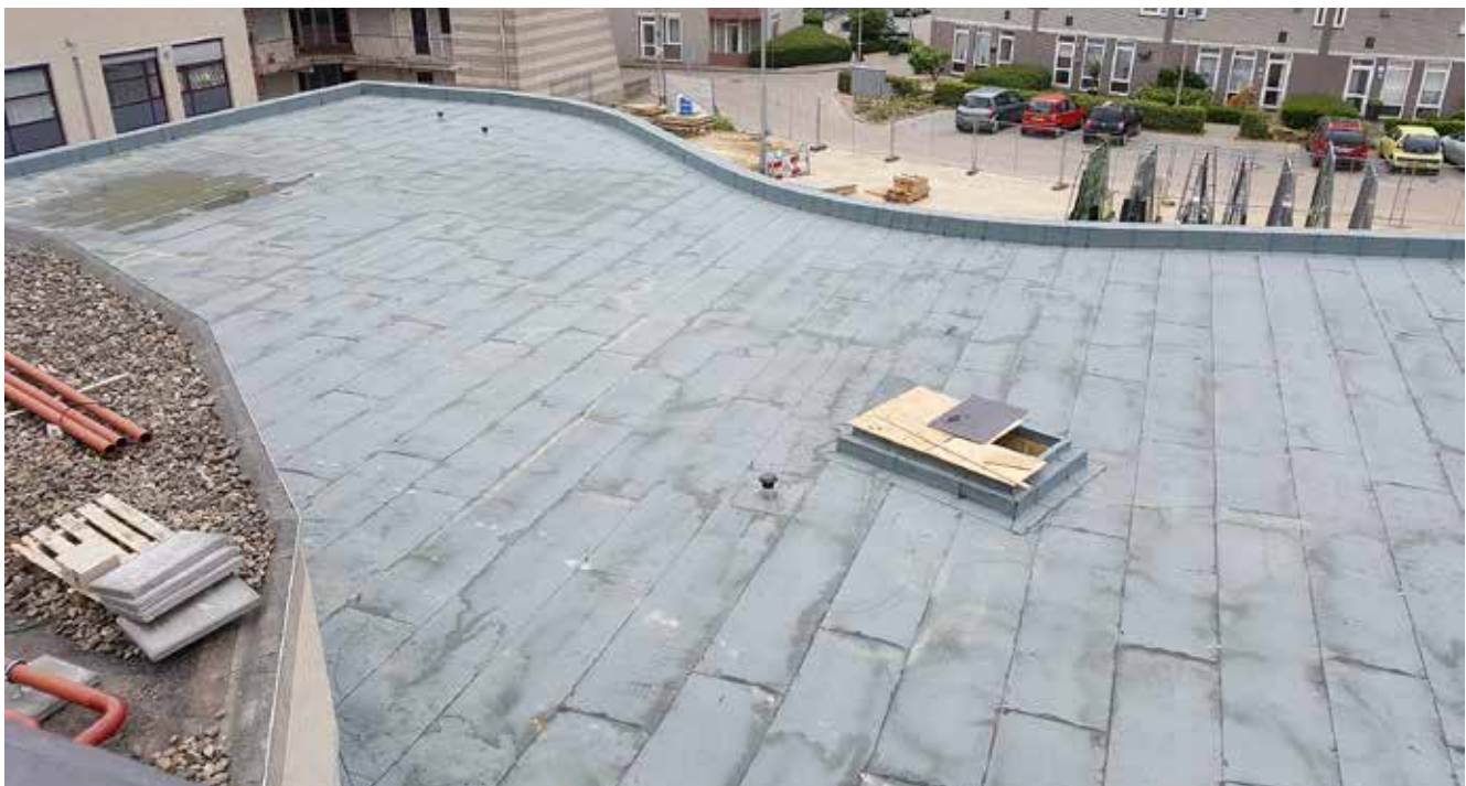
Het compactdaksysteem is afgewerkt met een gemineraliseerde wortelvaste toplaag.
