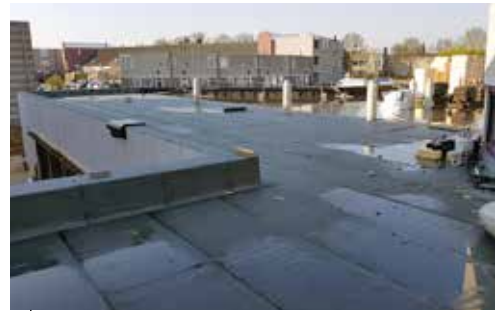
Het compactdaksysteem in opbouw.
